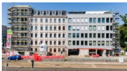
Sicht von der Stötteritzer Straße auf die Seniorenwohnungen am Campus Lorenzo. Ein Ende der Bauzeit ist absehbar.
